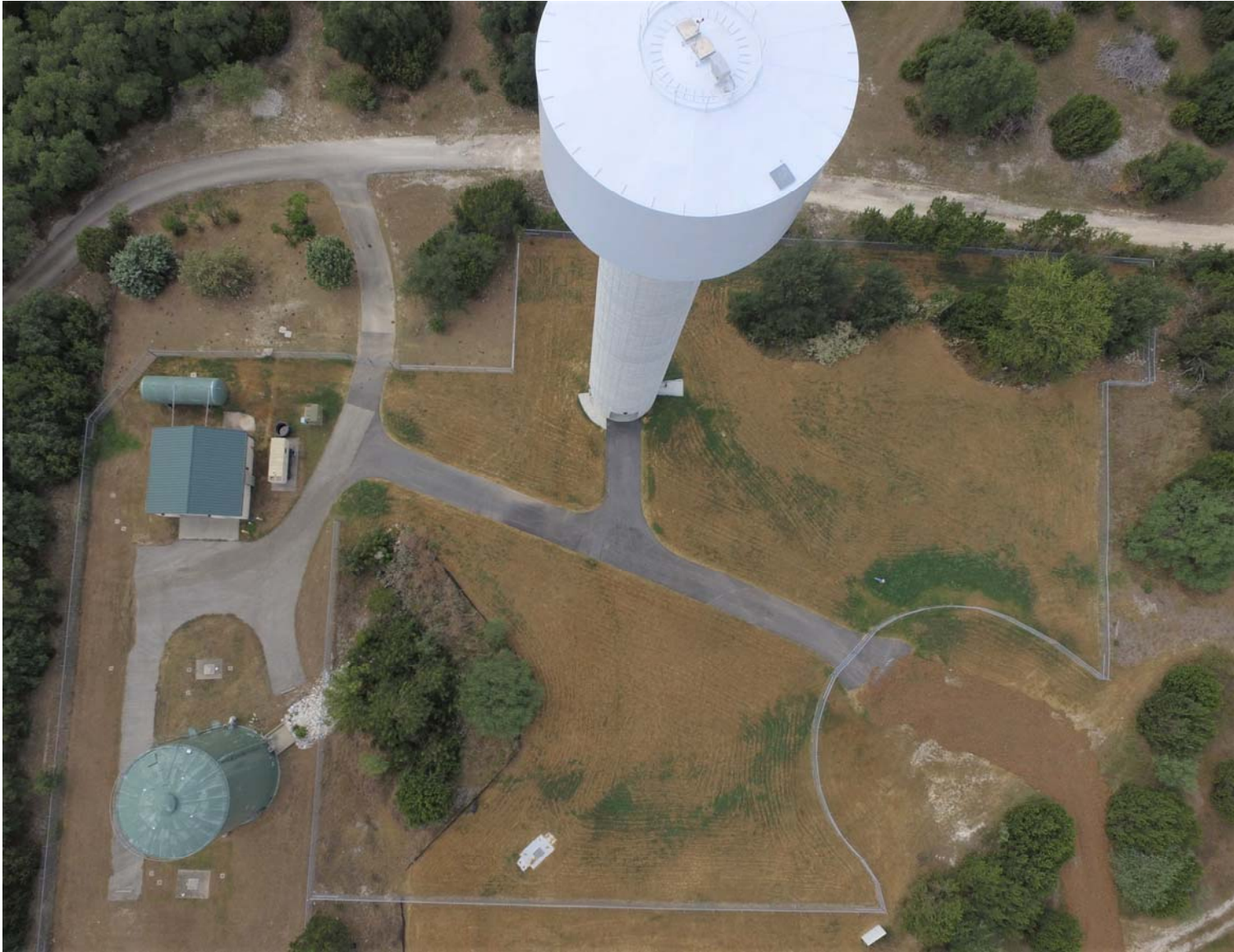
Travis County MUD 22 EST Site
